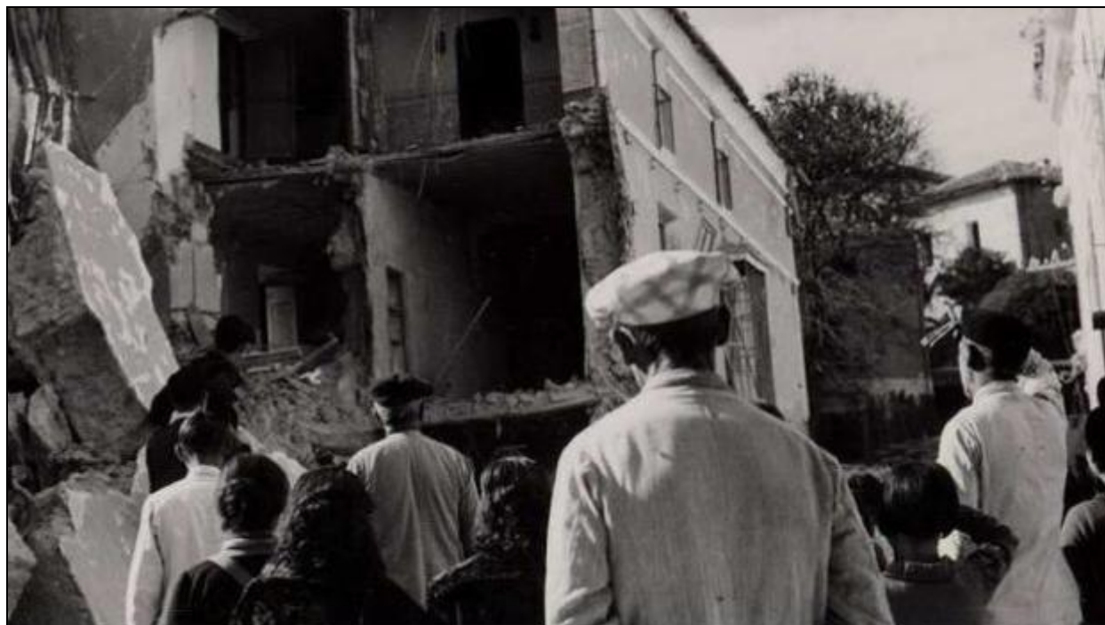
Vecinos de Cabra observando un edificio destruido. Foto de Cris Velasco. Biblioteca Nacional
