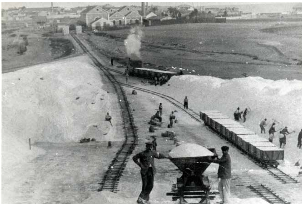
Despilamiento de la sal y conducción a la fábrica de triturado y a los muelles de embarque. Foto: Alberto Darblade
