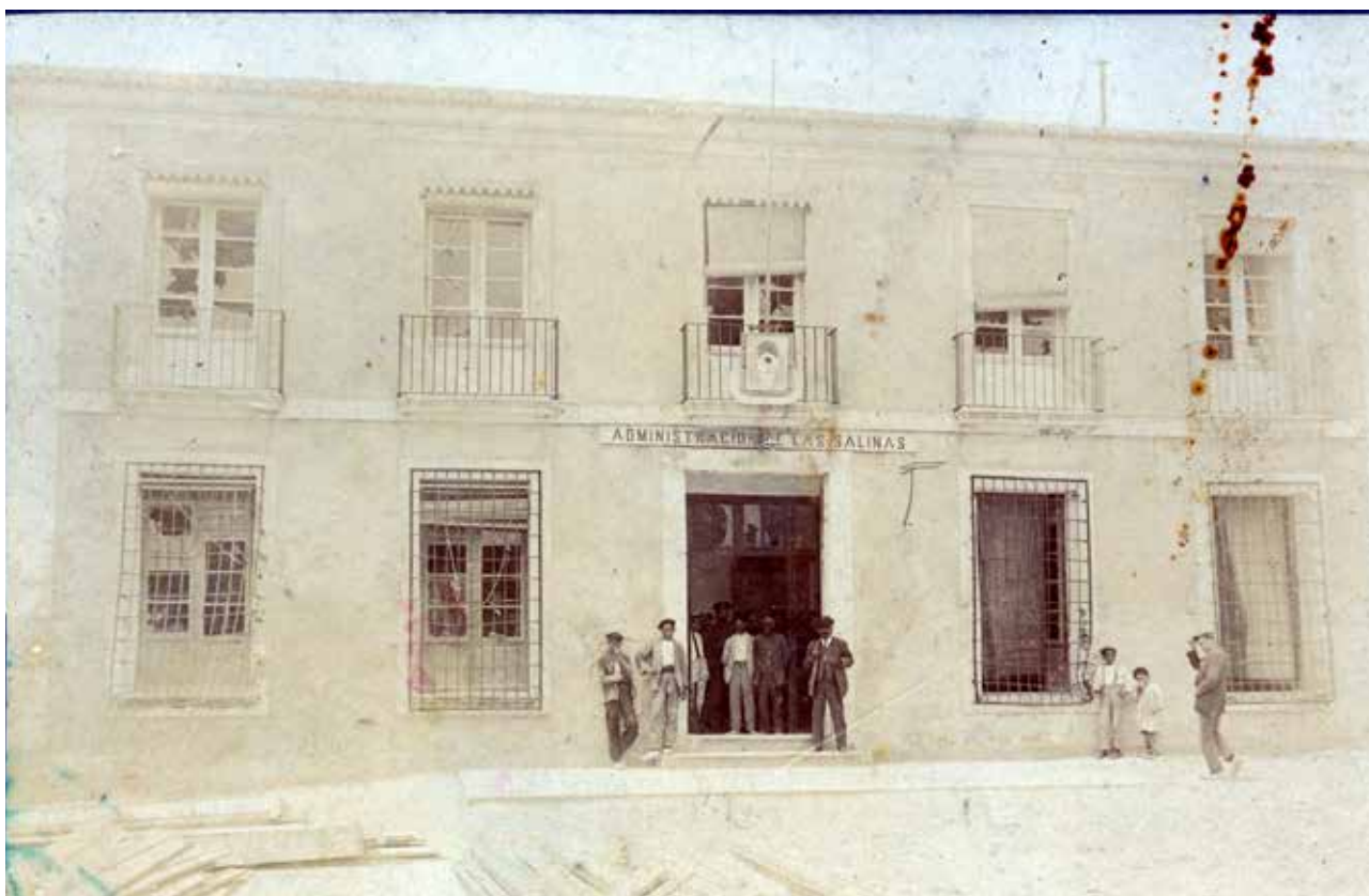
Las oficinas y casa-administración de las salinas después del asalto de los obreros en 1913. Foto: A. Darblade
